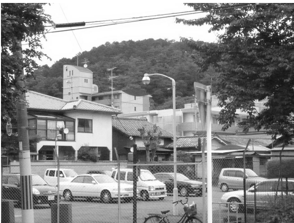
建物の高さ・デザイン、駐車場に配慮がない
